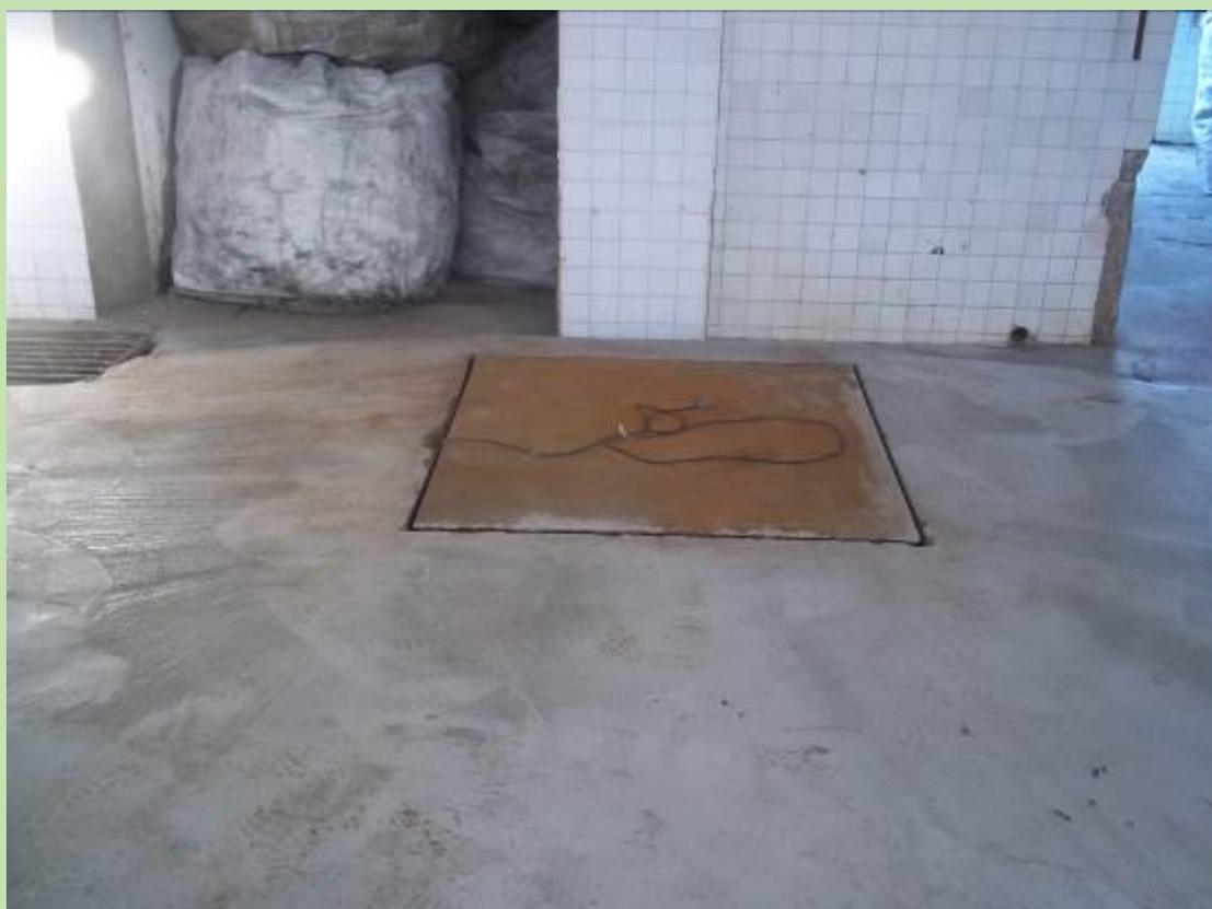
***BALANZA YA COLOCADA EN LA FOSA QUE SE REALIZÓ A MEDIDA.***
